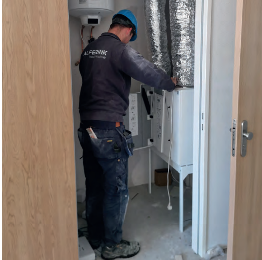
Naast de luchtdichtheid wordt ook de geluidsisolatie van de wtw-units getest.
